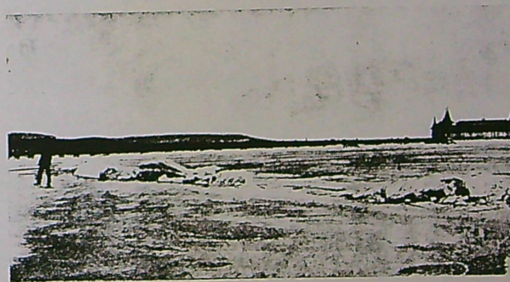
96. ábra. Vastag jégből képződött turolás, áttolt részlettel (chariage). A 95. ábrán látható turolásnak a folytatása a part felé.
